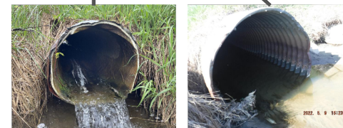
10. Culvert 3: CSP 500 mm Ø
